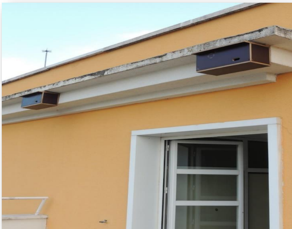
Cajas nido para Vencejo común instaladas en el Hospital Psiquiátrico de Álava.
