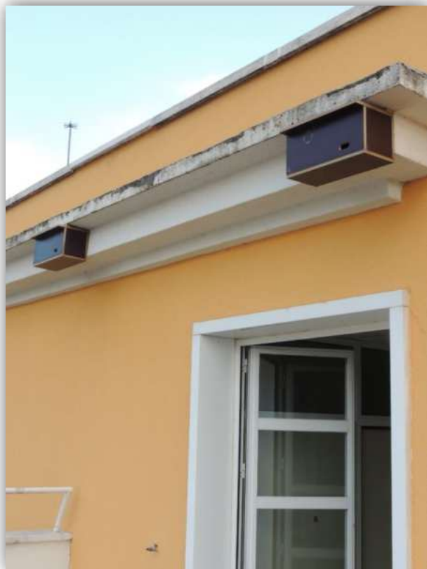
Cajas nido para Vencejo común instaladas en el Hospital Psiquiátrico de Álava.
