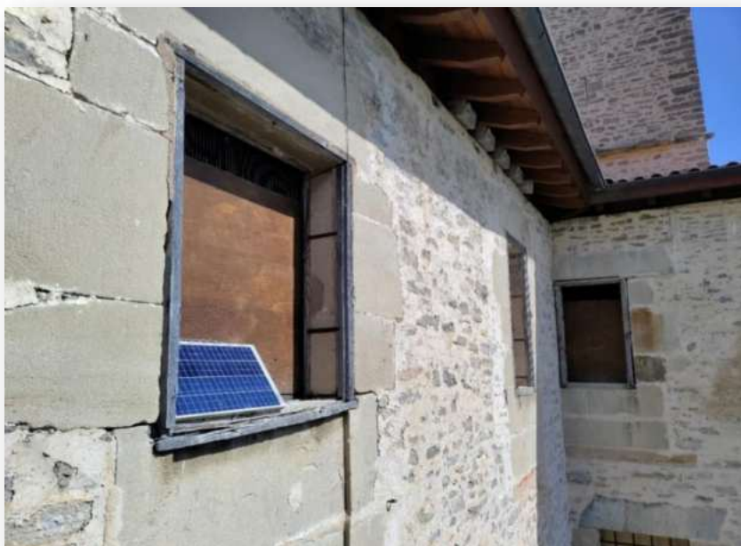
Instalación automática de reclamos de vencejo en Mártioda
