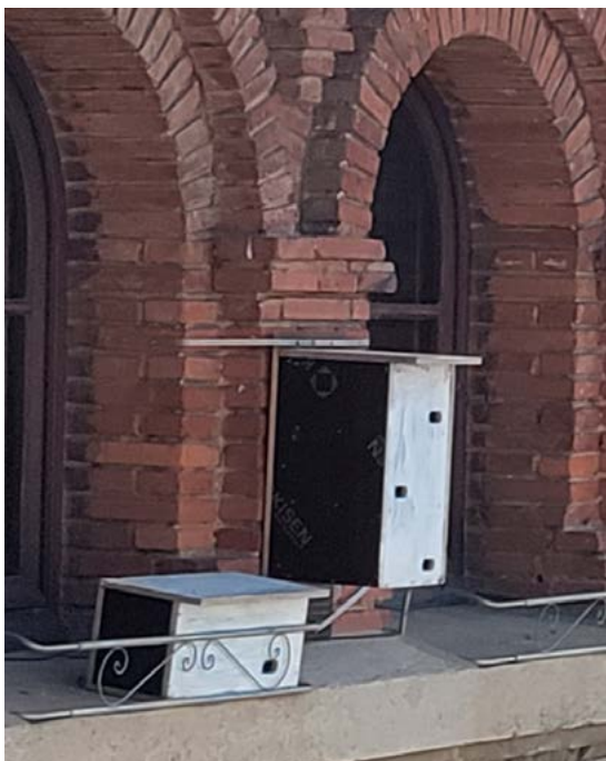
Algunas de las cajas de la instalación de cajas nido en el exterior de las oficinas del Instituto Alavés de la Naturaleza. Se pintan de blanco para reducir la temperatura en días soleados.
