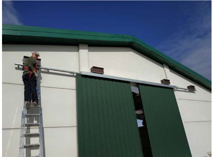
Colocación de cajas nido para vencejo común en Caranca.
